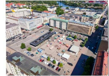
Kauppatorin uudistuminen alkoi uuden Toripaviljongin myötä. Rakennus valmistui vapuksi 29.4.2020. Toripaviljongissa toimivat nykyään Hesburger ja R-kioski. Siellä on myös torikauppiainien käytössä oleva varasto ja yleisö wc:t. Kuva Tomi Glad.
